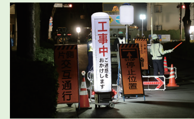
夜間の工事現場
