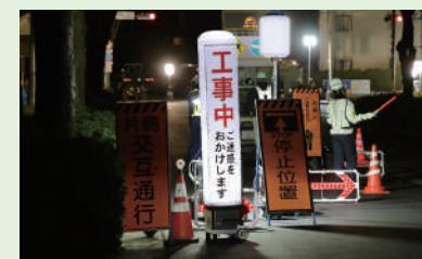
夜間の工事現場
